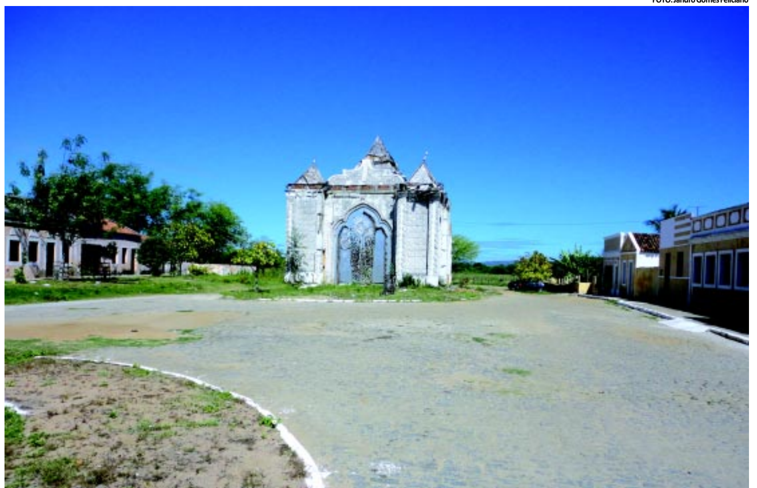
A capela, construída para ser cenário da minissérie da Rede Globo, acabou tornando-se um atrativo da cidade, mas falta cuidado com o imóvel
